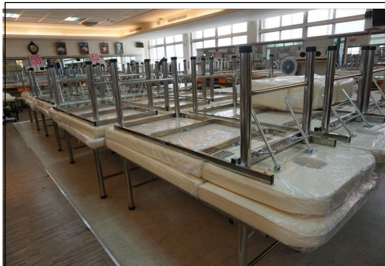
至美樓專業教室整修工程
