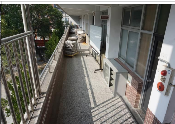
至美樓專業教室整修工程
