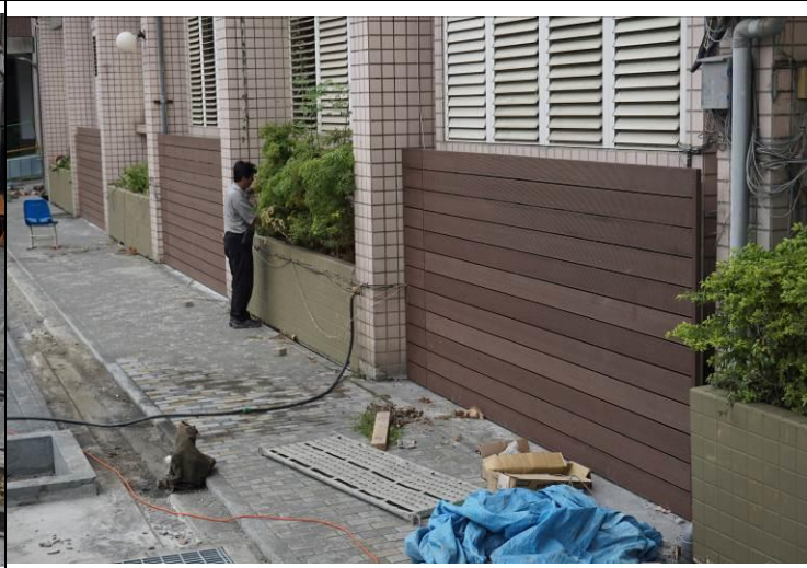
行政大樓外牆造型框架美化工程
