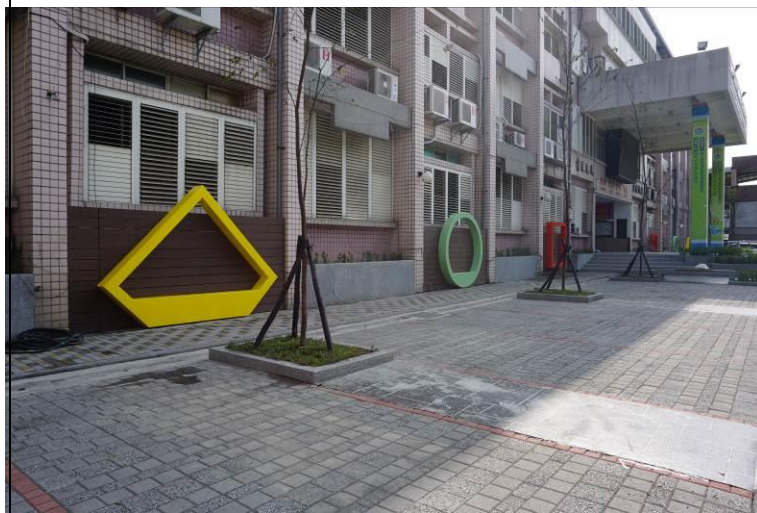
行政大樓外牆造型框架美化工程
