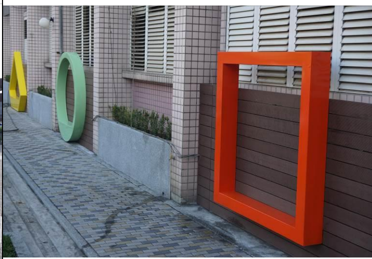
行政大樓外牆造型框架美化工程
