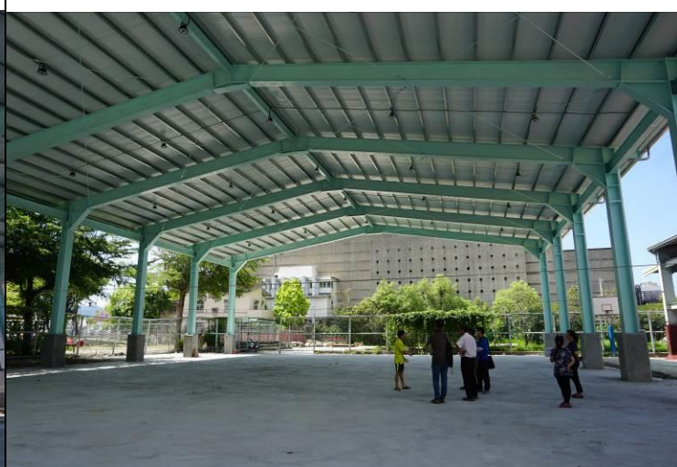
風雨球場增建工程
