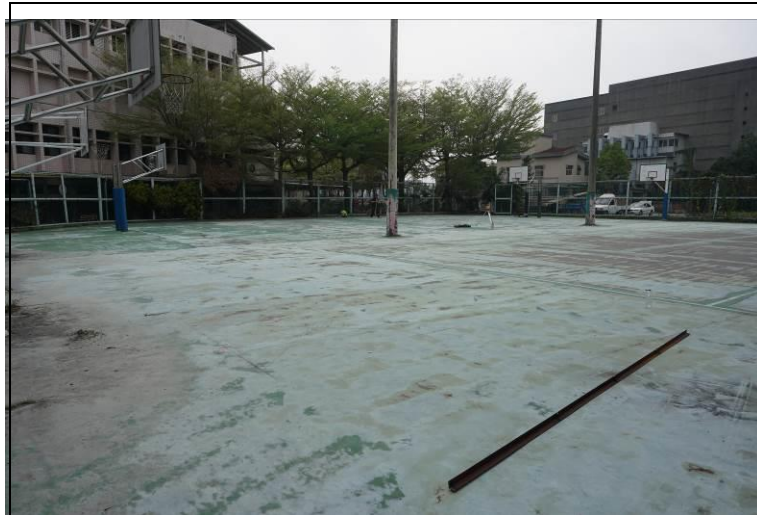
風雨球場增建工程
