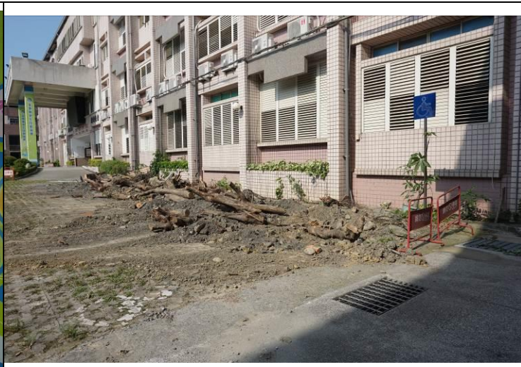
行政大樓外牆造型框架美化工程
