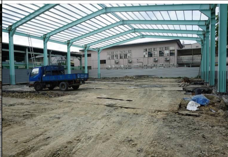
風雨球場增建工程
