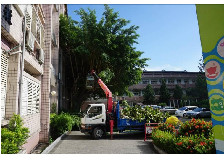
行政大樓外牆造型框架美化工程
