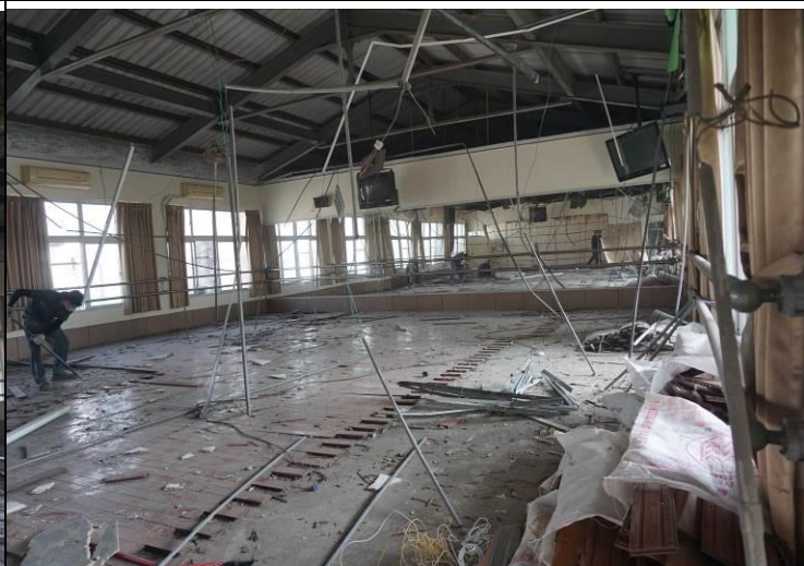
至美樓專業教室整修工程
