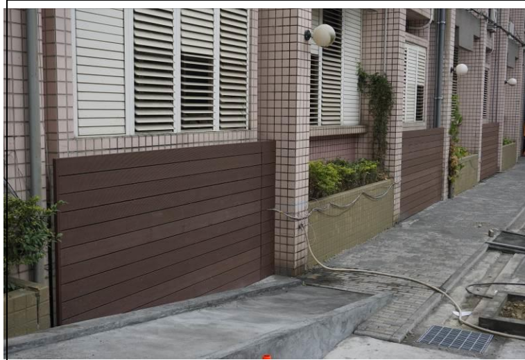
行政大樓外牆造型框架美化工程
