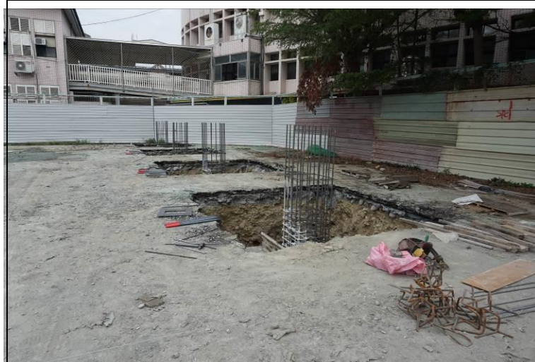
風雨球場增建工程
