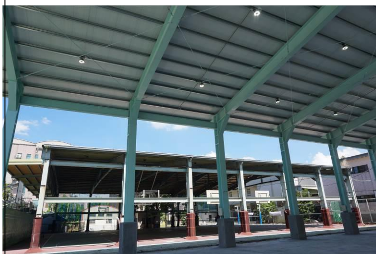
風雨球場增建工程
