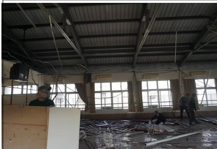
至美樓專業教室整修工程
