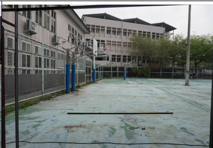
風雨球場增建工程
